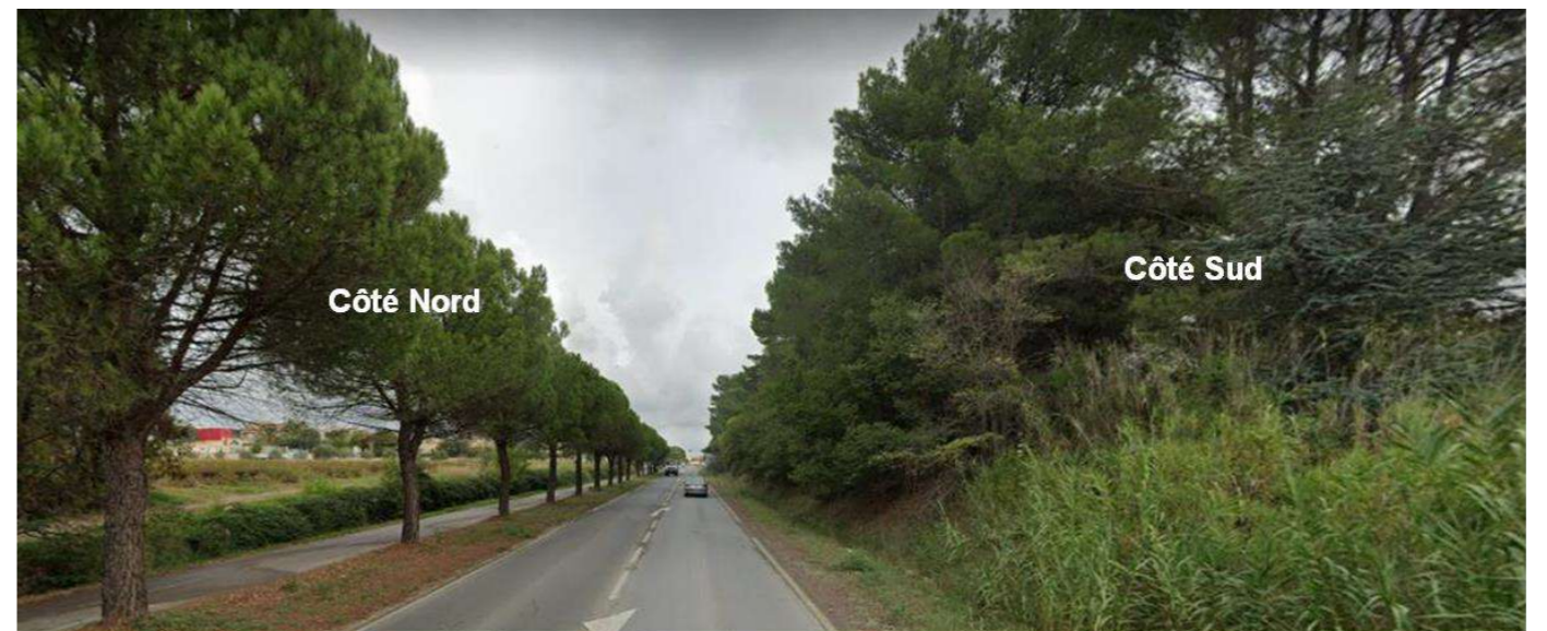
Figure 37 : Photo de l'état actuel du secteur Sortie Ouest de Lavérune vers Pignan
